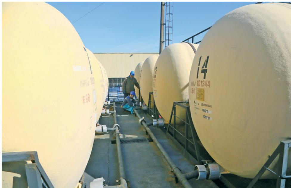
Сергей Веденин и Раим Нигматуллин выполняют протяжку фланцевых соединений на кислотных емкостях
