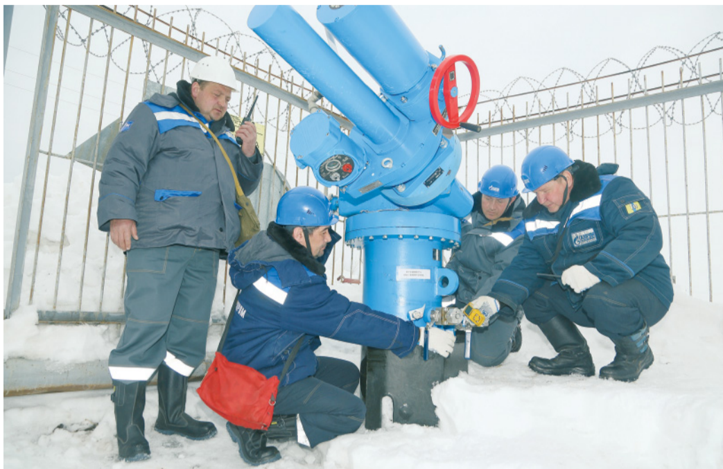
Начальник участка № 2 Андрей Шумилин и слесари по ремонту технологических установок Денис Зюмалин, Михаил Синцев и Александр Бунин проводят проверку работоспособности запорной арматуры
