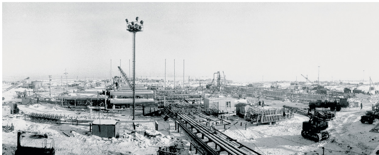
Строительство установки комплексной подготовки газа № 10. 1977 год
