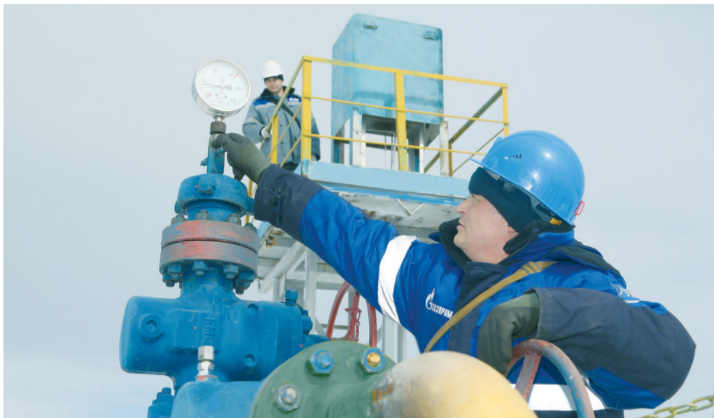
Александр Прочанкин и Дмитрий Рябов (на первом плане) проводят проверку автоматики безопасности на скважине
