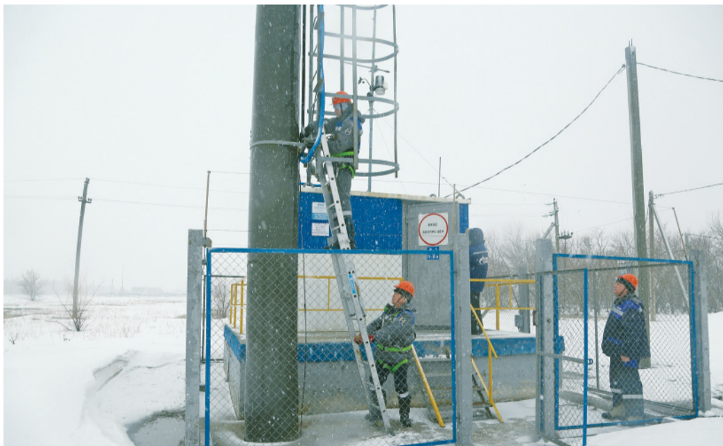
Связисты приводят в состояние полной готовности более 300 антенно-мачтовых сооружений
