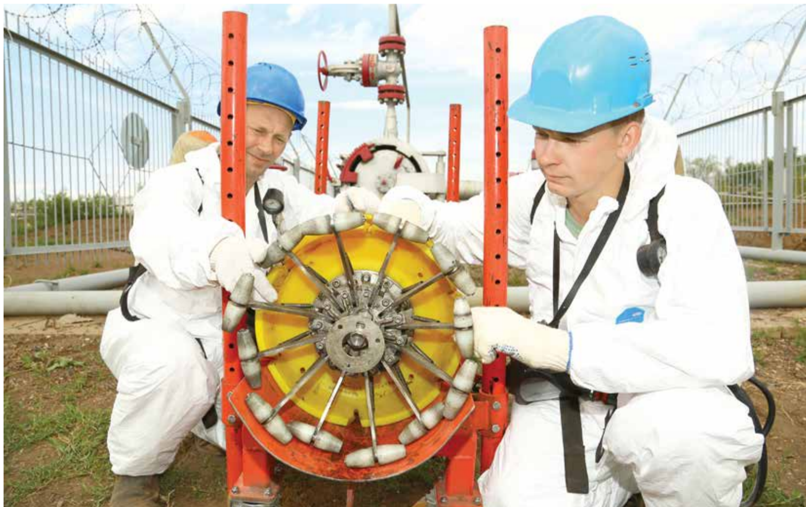
Трубопроводчики линейные Александр Бунин и Александр Креймер готовятся «запасовать» профилемер
