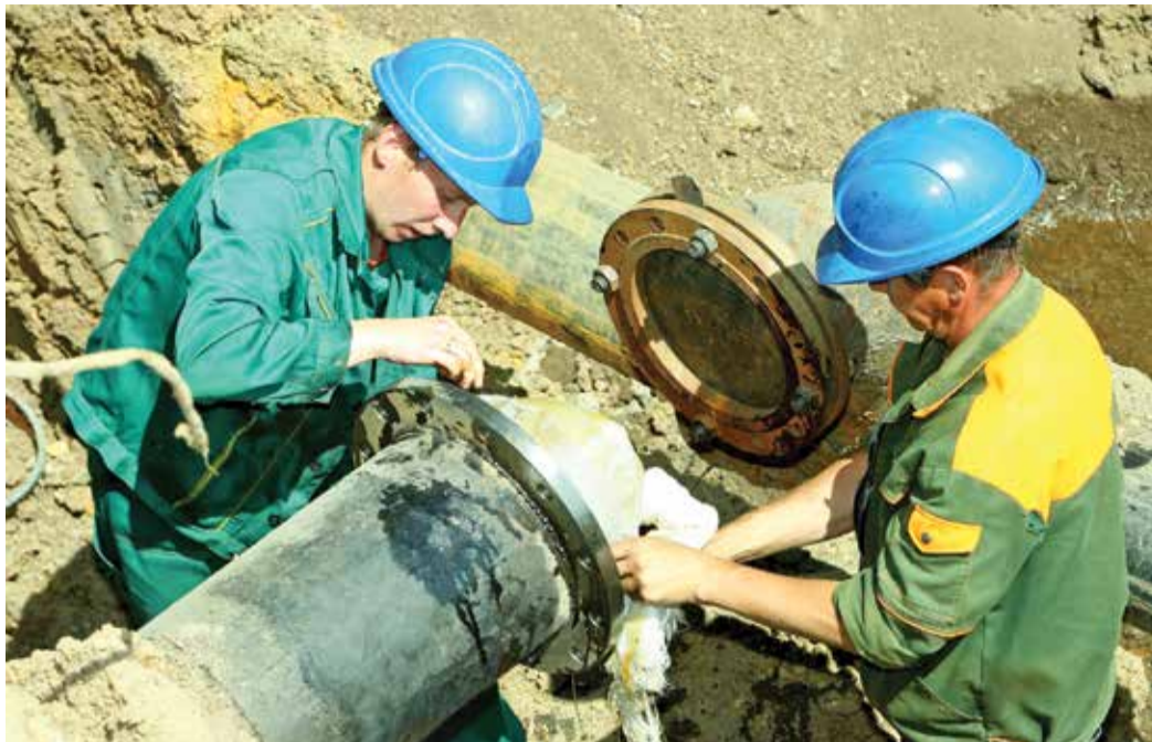
«Рукав» уже в трубе
