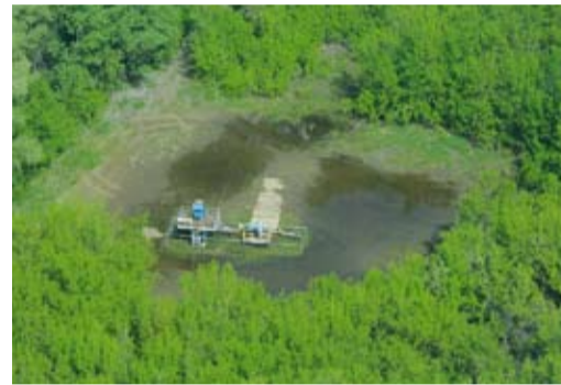
Вода отступила. Но запускать нефтяную скважину № 14016 пока рано: тяжелая техника к ней не пройдет
