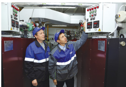
Новая автоматизированная котельная введена в эксплуатацию в ЛЭС № 2 Октябрьского ЛПУ управления по эксплуатации соединительных продуктопроводов
