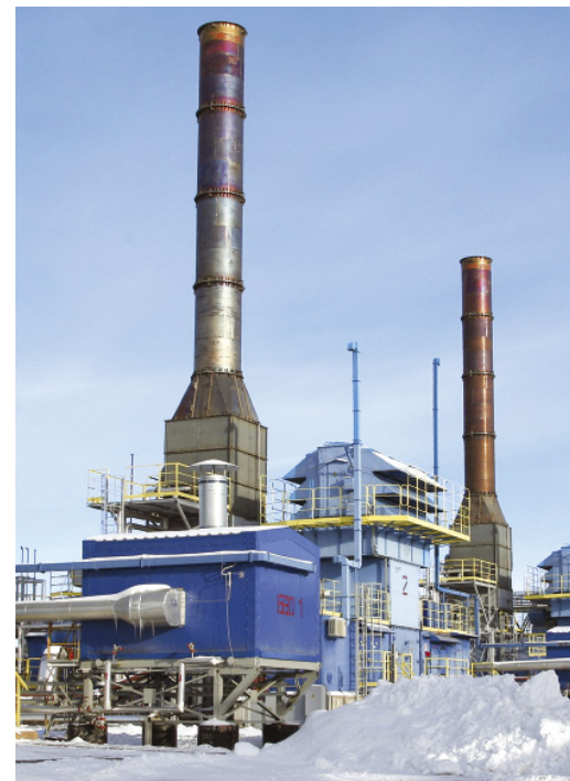
Газ с промыслов № 14 и 15 в полном объеме поступил на дожимную компрессорную станцию № 3. 2007 год
