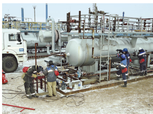
Пятая технологическая линия для приема нефти и повышения качества ее подготовки смонтирована в цехе по добыче нефти, газа и конденсата газопромыслового управления
