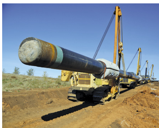
Перекладка подводных переходов трубопроводов на реках впервые выполнена силами работников УЭСП и УАВР. В работе участвовали 112 человек и 48 единиц техники
