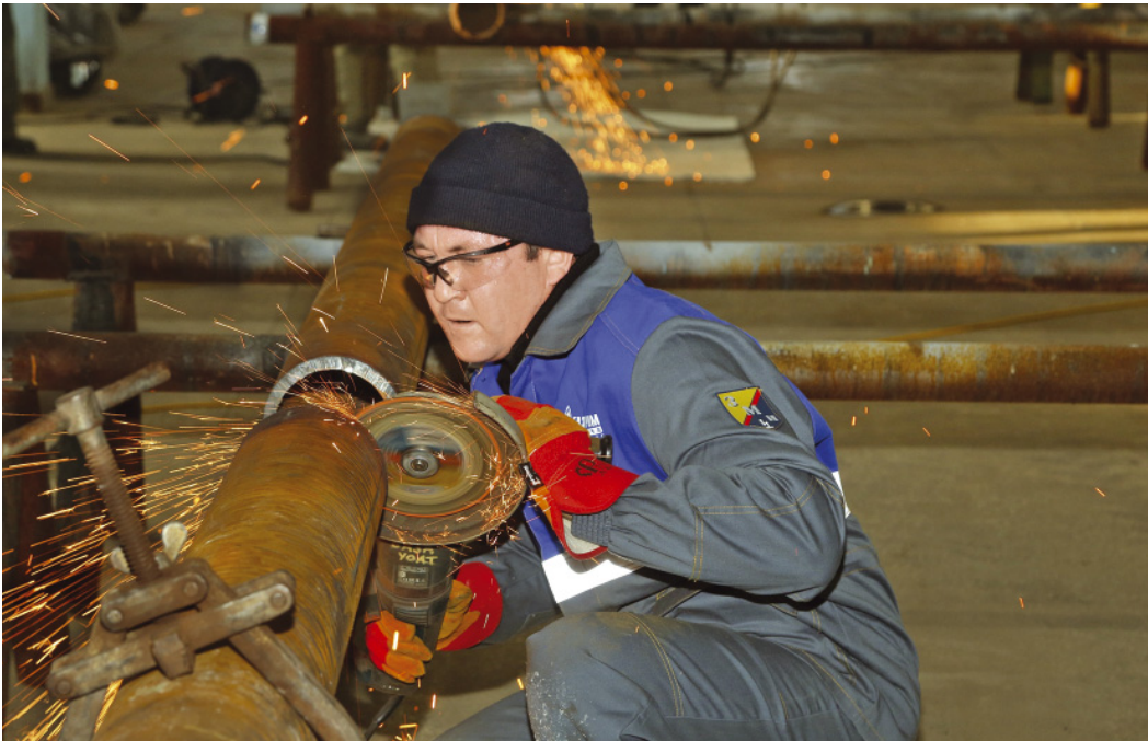
Монтажник технологических трубопроводов Рифат Исхаков выполняет подготовку кромки трубы к сварке
