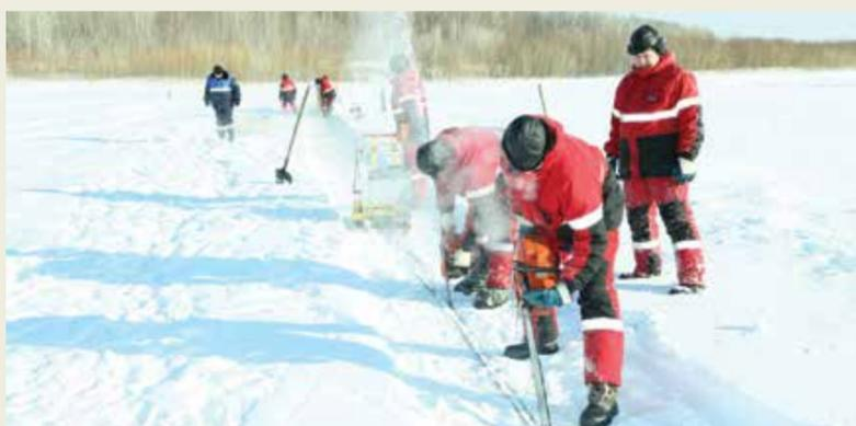
Толщина льда — от 35 до 70 сантиметров, нужно прорезать в нем «дорожку». Взрели бензопилы... Задача усложняется тем, что в составе льда много гравия. А это затрудняет работу бензопил.
