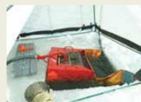
Работники УЭСП готовят майну — так называют небольшую прорубь у самой «нижней» точки рубежа. В нее вдоль щитов потечет нефтепродукт. В майну устанавливается насос, с помощью которого разлитый конденсат откачивается в специальную емкость на берегу.
