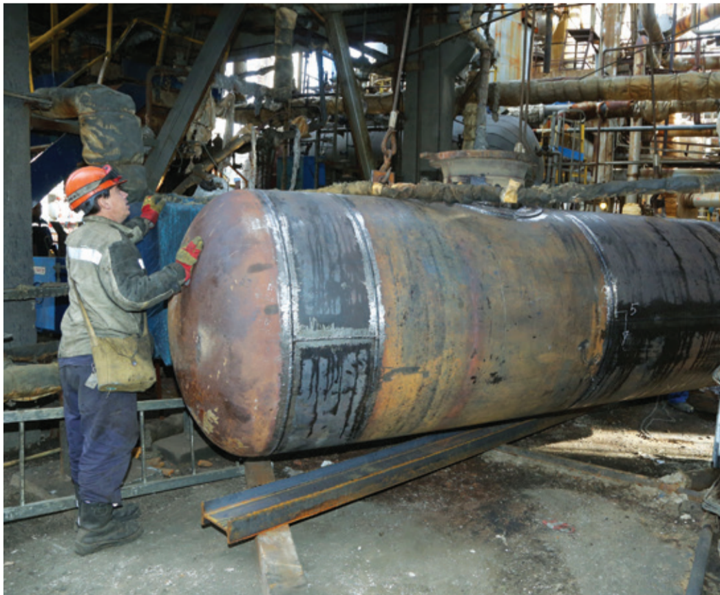
Протащить обновленную емкость на место — занятие не из простых, ведь на пути — множество пересекаемых коммуникаций
