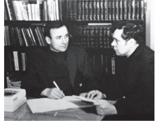
Александр Соловых (слева) и начальник РМУСМР № 5 Александр Золотарев в комсомольском штабе стройки. 1970-е годы
