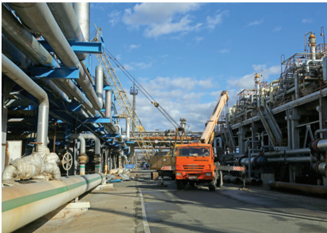
В ремонте очереди было задействовано шесть подъемных кранов
