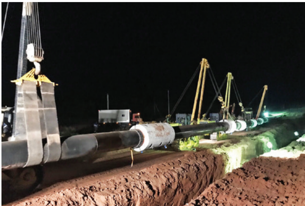
Переукладка подводного перехода на реке Ключ-Рычковка. Ночью работы велись с соблюдением дополнительных мер безопасности
