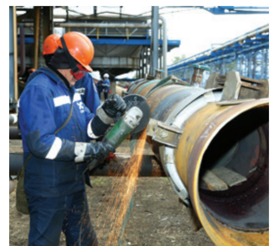
Ведется зачистка сварных швов
