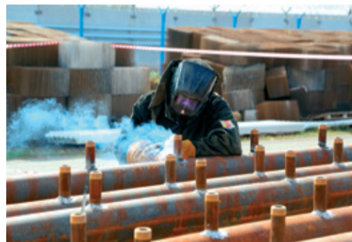
Ведутся сварочные работы
