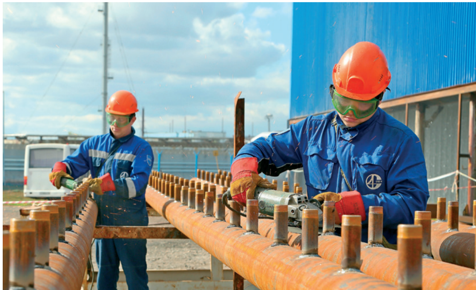
Монтажники готовят к установке трубные заготовки системы орошения градирни
