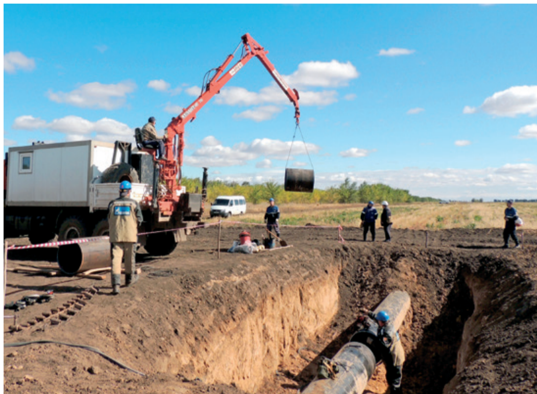
Участок газопровода, который подлежал замене, извлекли из траншеи с помощью грузоподъемной техники
