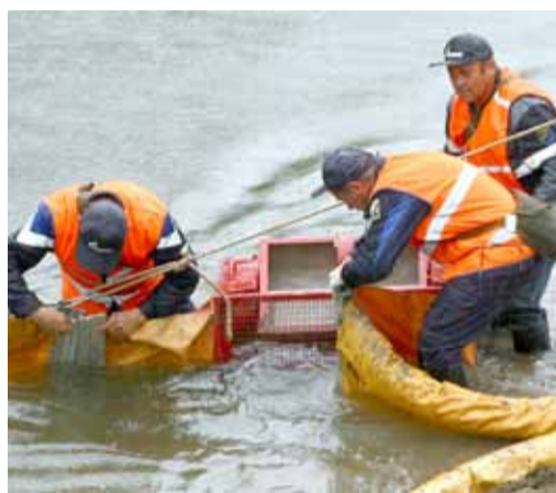
Работники Октябрьского ЛПУ устанавливают нефте-сорбное оборудование
