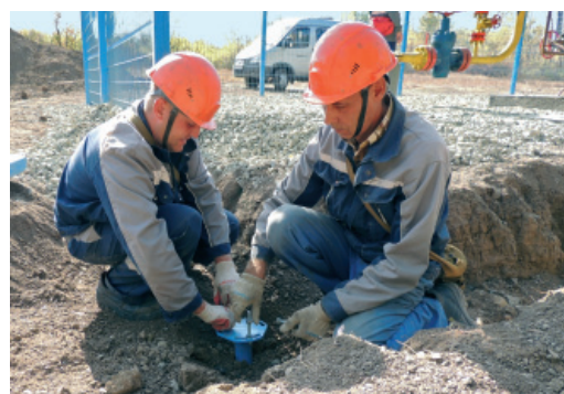
Завершается монтаж нового ограждения скважины № 15032
