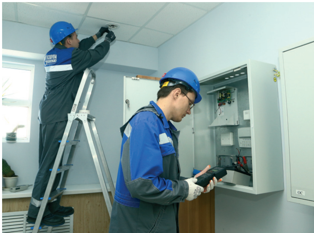
Слесари КИПиА Александр Пантелеев и Дмитрий Стрижаков ежедневно проводят техническое обслуживание противопожарной автоматики
