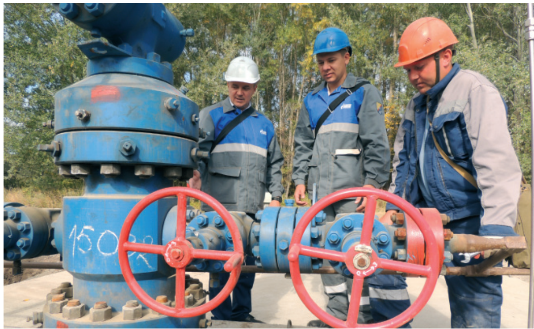
Начальник УКПГ-15 Виталий Неклесов, оператор Рашид Султанов и мастер подрядной организации Михаил Родимцев проверили готовность объекта к началу работ по креплению стенок шахтного колодца
