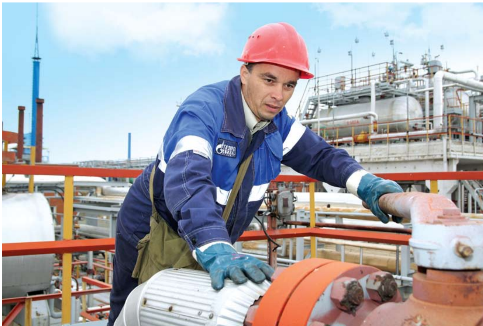
Ремонтируется один из сотен кранов
