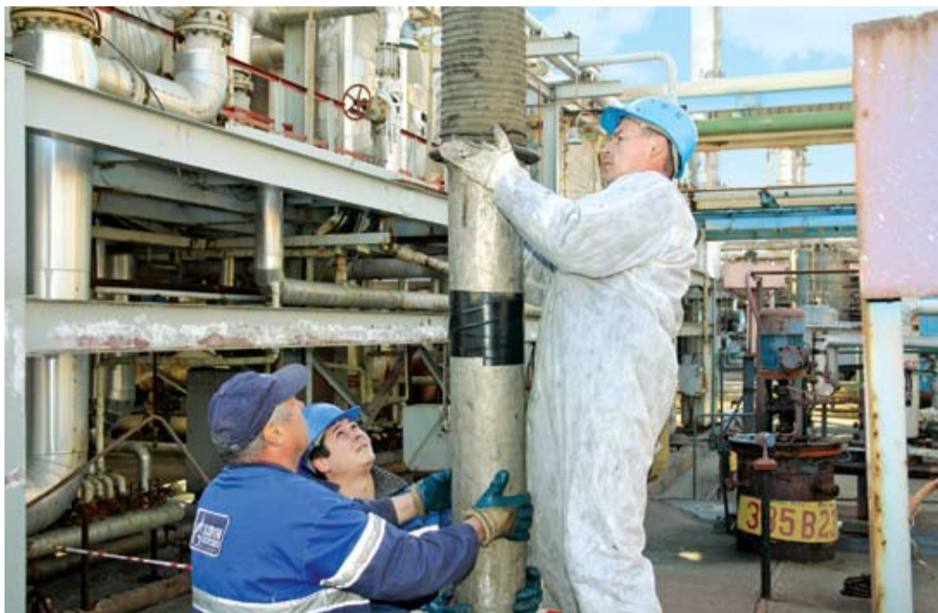
Ведутся ремонтные работы
