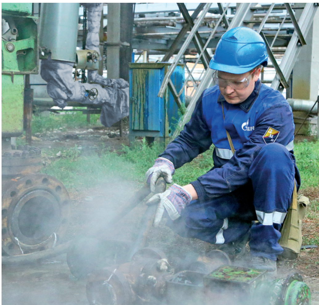
Оператор технологических установок Роман Безмельницин выполняет пропарку запорной арматуры
