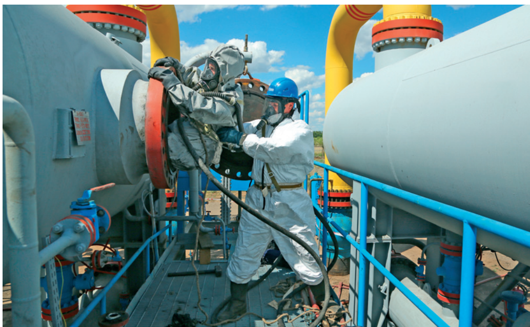
Машинисты Дмитрий Кириллов и Сергей Юринский проводят внутренний осмотр входного сепаратора
