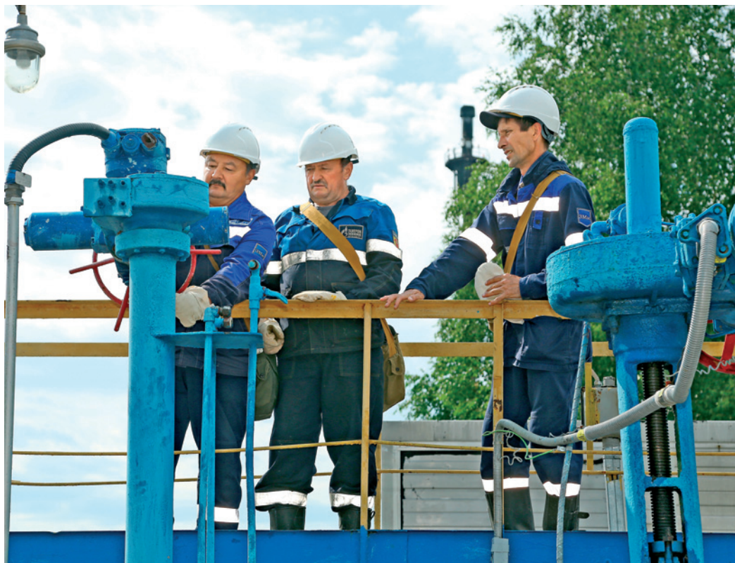
Трубопроводчик линейный Александр Токарев, электромонтер Яудат Гильмутдинов и инженер Ильфат Ханипов проводят техническое обслуживание трубопроводной арматуры
