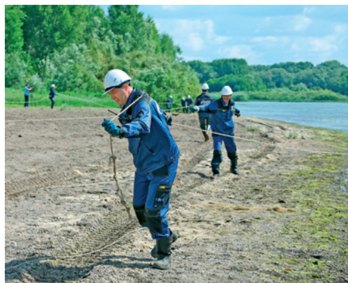
Установка бонового заграждения
