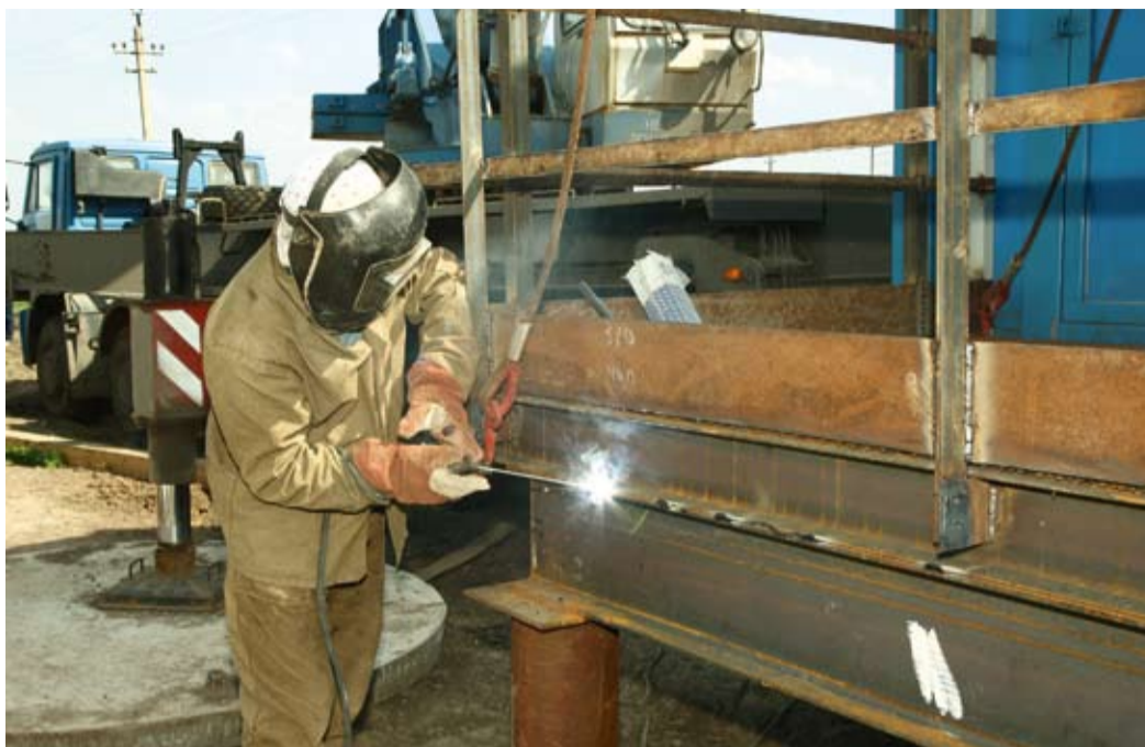
Ведется монтаж здания подстанции
