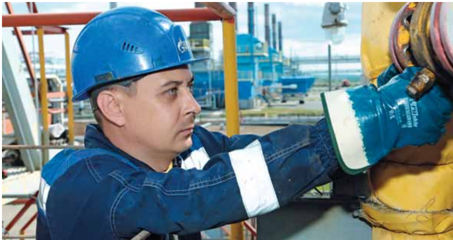
Машинист технологических насосов Владимир Попов демонтирует шаровый кран для проведения ревизии
