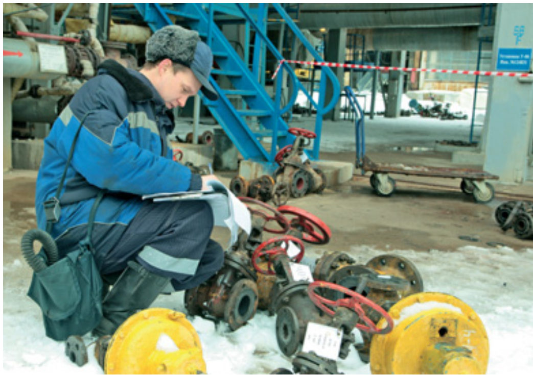
Механик Максим Тямкин ведет описание демонтированных кранов
