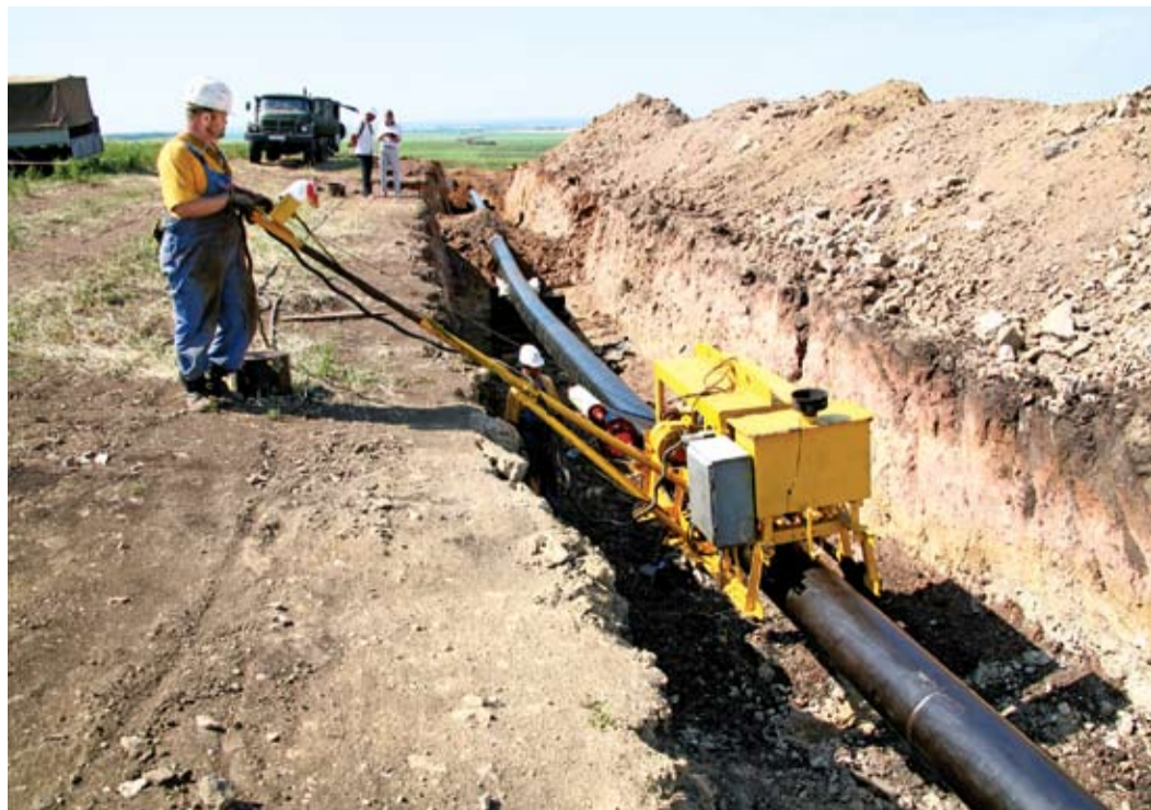
Выполняется автоматизированная изоляция трубопровода
