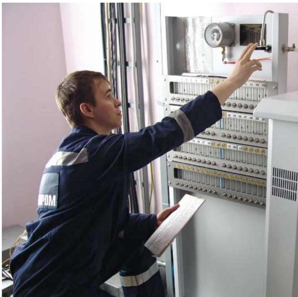
Кабельщик-спайщик Руслан Аюпов проводит контроль воздушного давления в кабельных линиях связи
