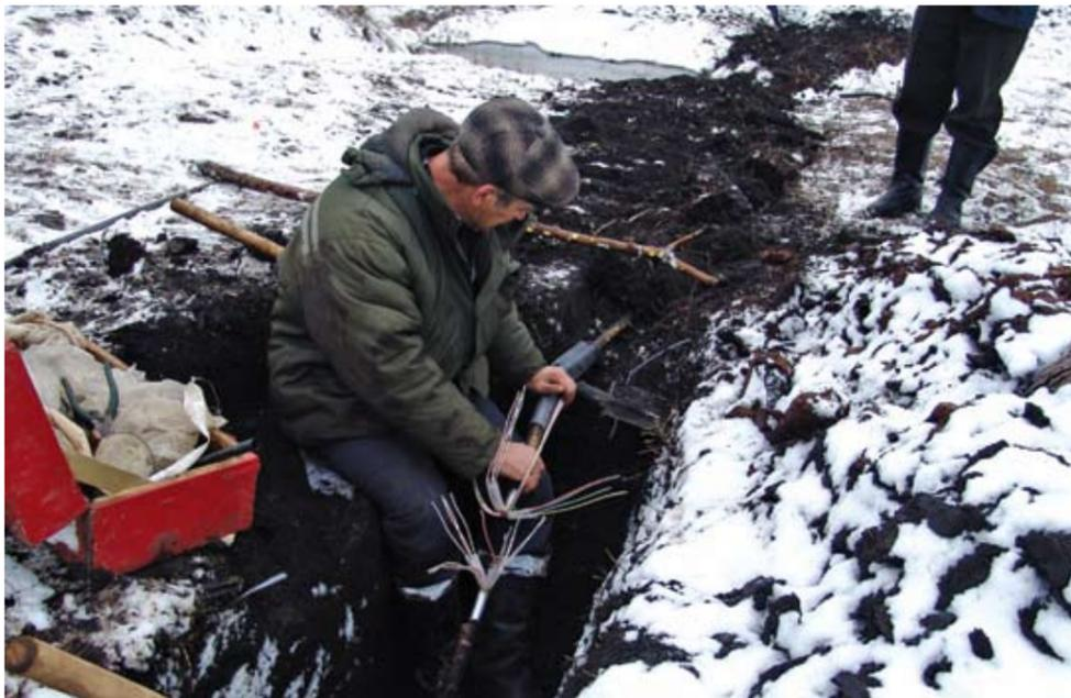
Идет монтаж соединительной муфты магистрального кабеля связи
