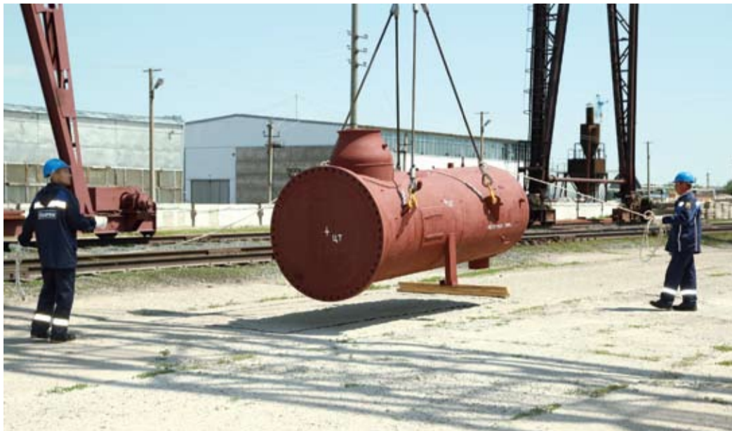
Стропальщики за работой
