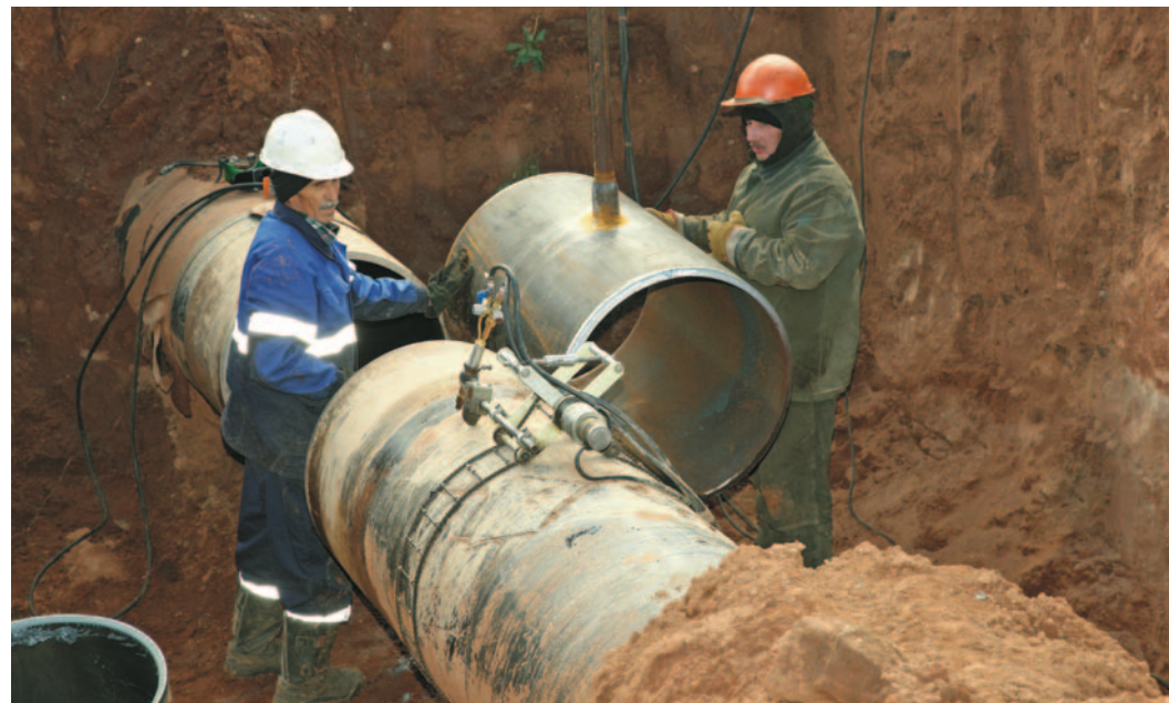
Идет монтаж стояка отбора на трубопроводе
