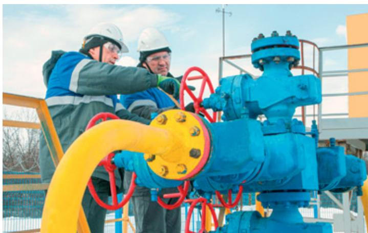
**Операторы по добыче нефти и газа Кирилл Чайкин и Виталий Казанев проводят осмотр фонтанной арматуры на скважине**
