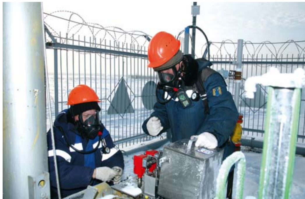
Обслуживание автоматов аварийного закрытия кранов Дедуровского коридора
