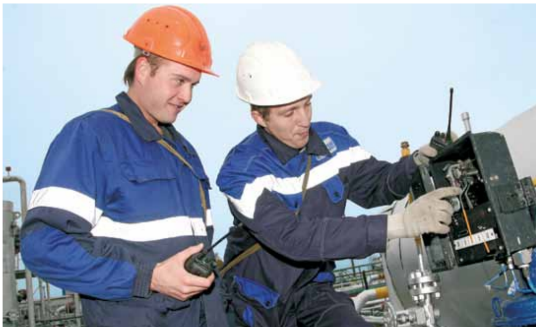
Ведется контроль за работой оборудования
