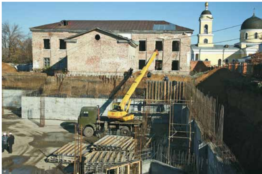
Ведутся строительные работы
