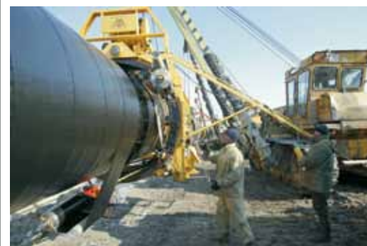
Ведется переизоляция газопровода
