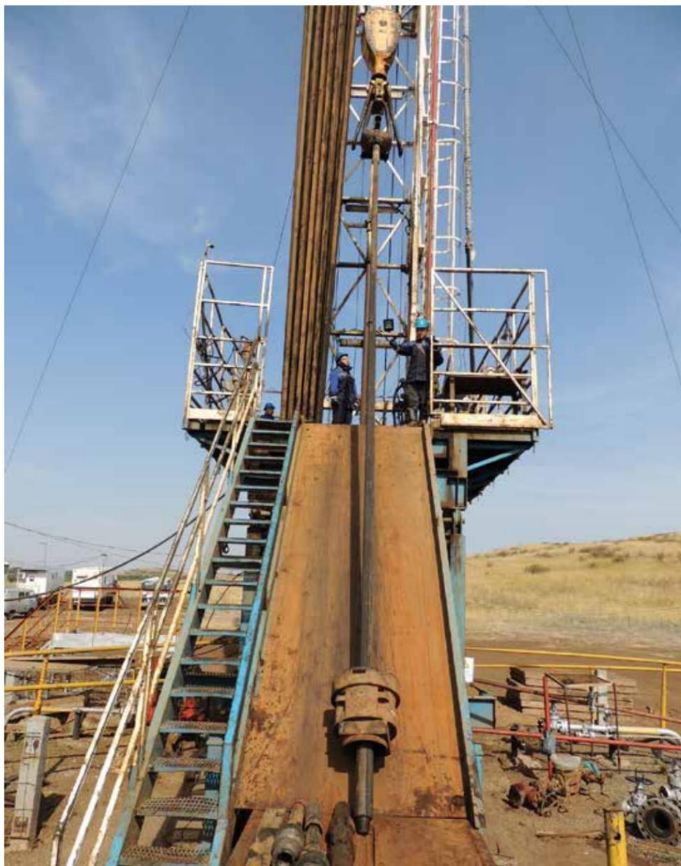
В рамках капитального ремонта на скважине № 15059 ведется подключение ведущей трубы буровой колонны
