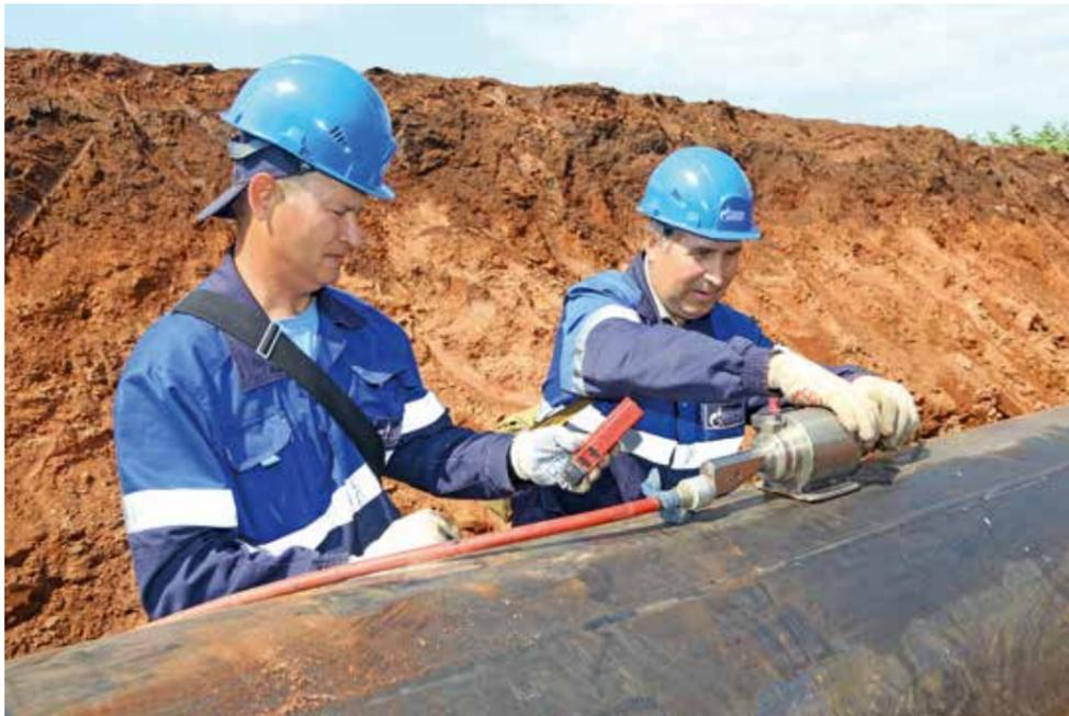
Дефектоскописты Сергей Зверев и Василий Захаров готовятся проводить радиографический контроль сварных стыков
