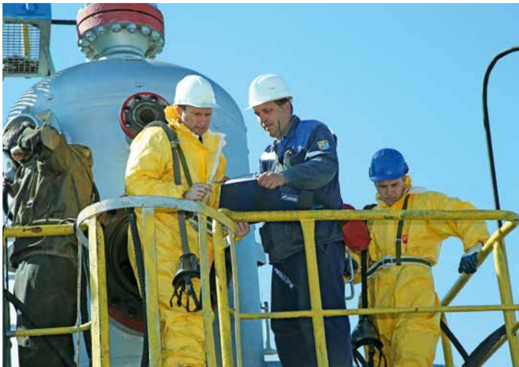
Подготовка к внутренней очистке сепаратора
