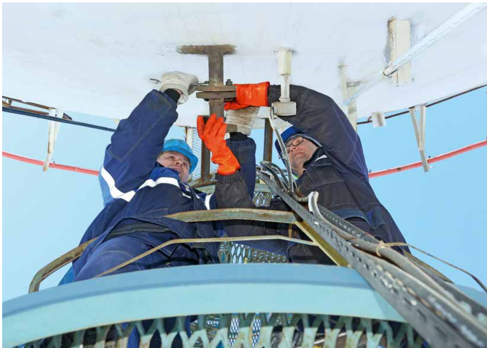
Операторы Виктор Стуколов и Александр Любимов ведут монтаж датчика уровня резервуара
