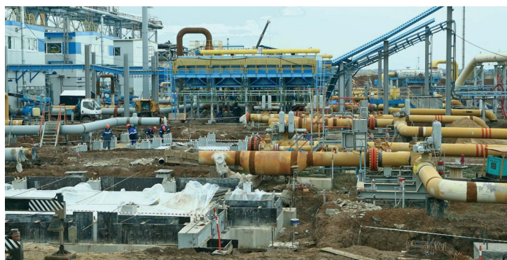
Каждый день на площадку реконструкции ДКС № 2 выходят порядка 300 человек и 40 единиц техники
