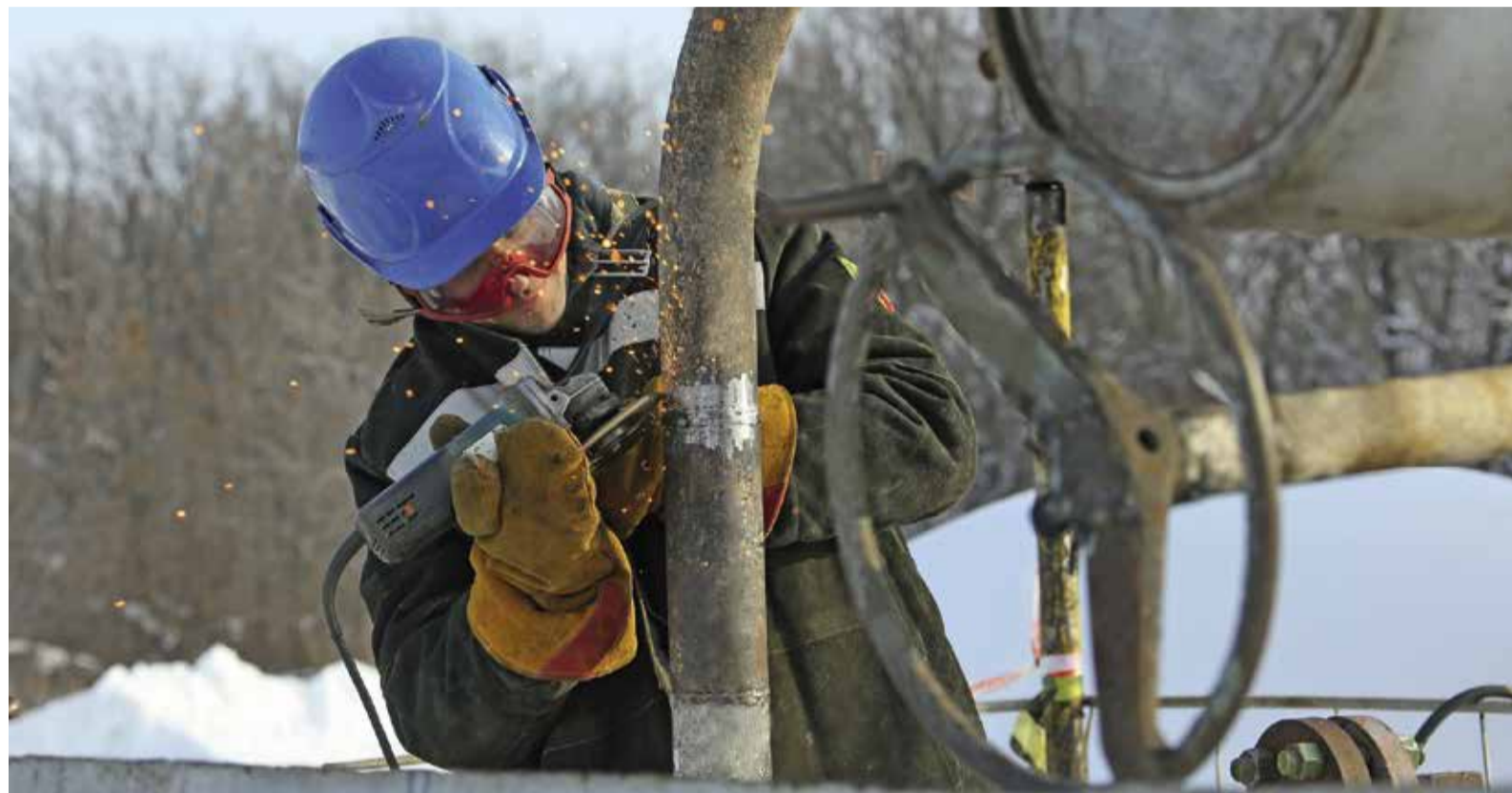
Григорий Иноземцев зачищает сварные соединения
