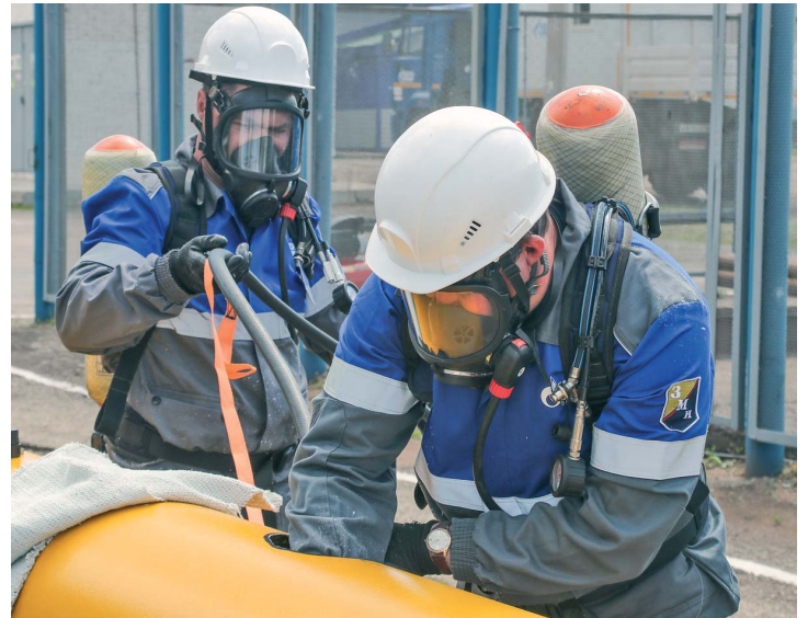
Трубопроводчики линейные за установкой временного герметизирующего устройства
