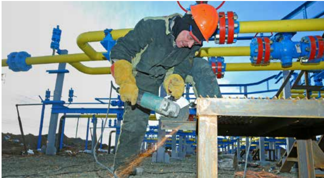
Подрядчики завершают монтаж сборно-распределительной гребенки № 5
