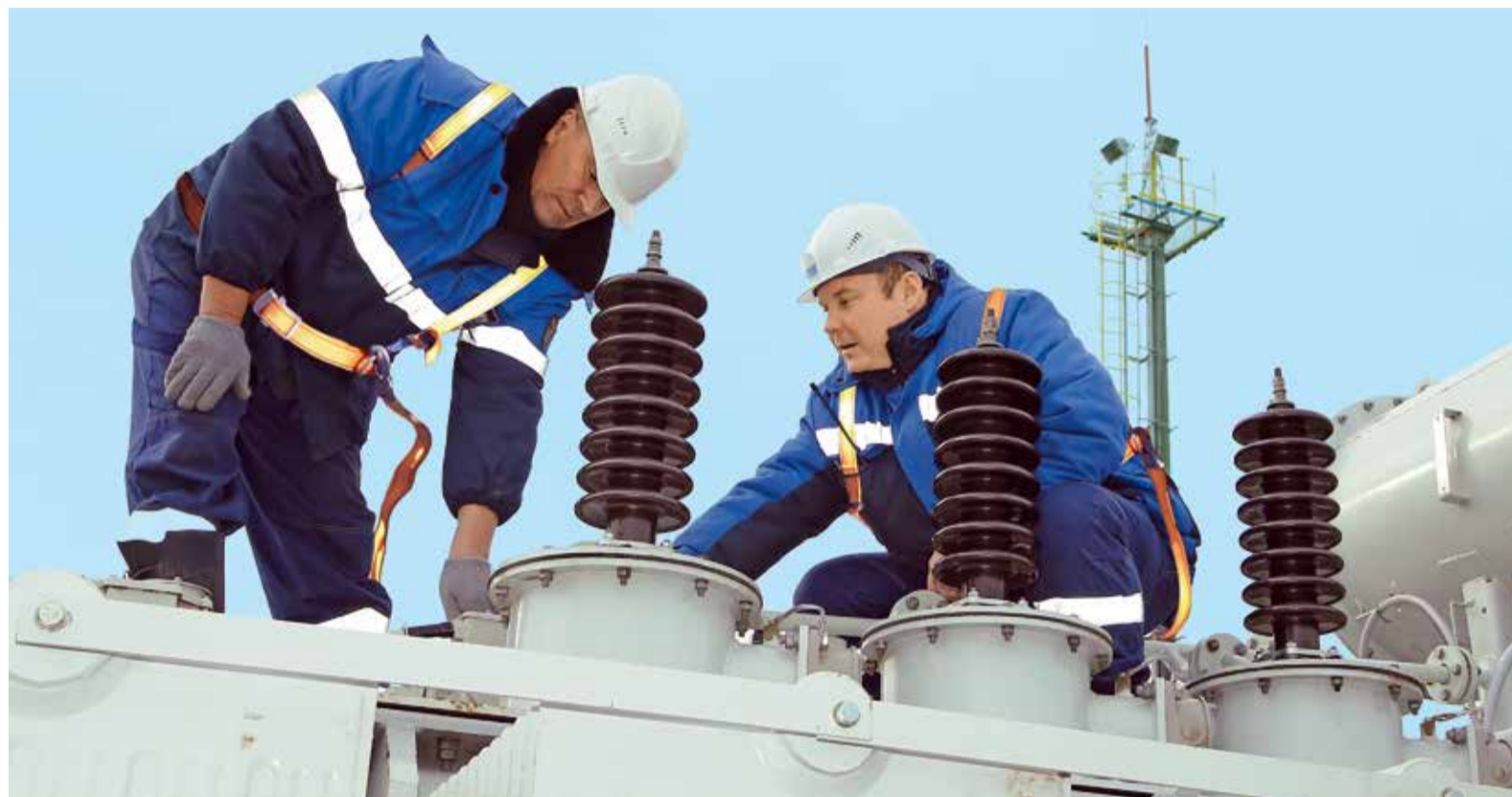
Электромонтер Евгений Жарков (слева) и старший мастер службы энергоснабжения газопромыслового управления Александр Терещенко контролируют качество сборки трансформатора
