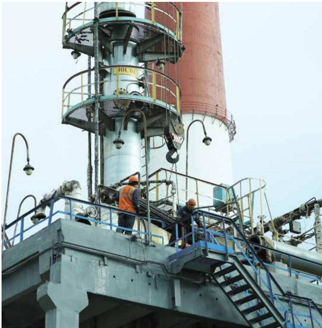
Ведется ремонт теплообменника на блоке регенерации раствора моноэтиленгликоля
