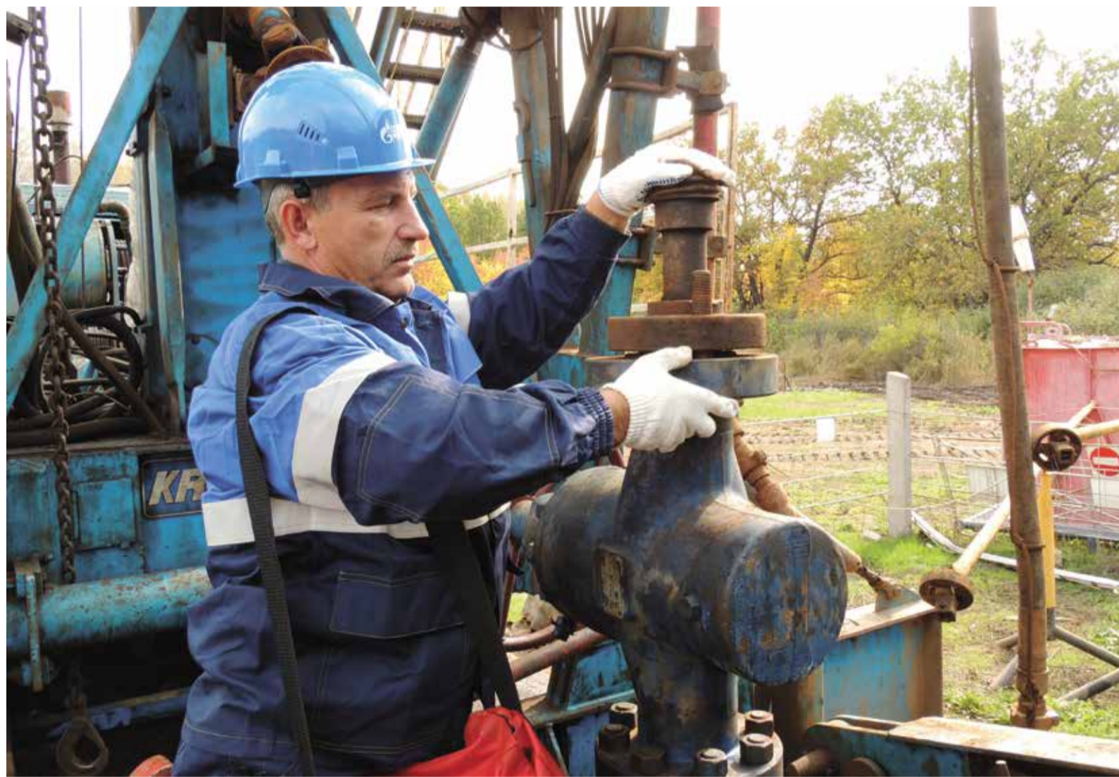
Оператор по добыче нефти и газа Александр Сорокин подготавливает скважину к проведению гидроразрыва пласта
