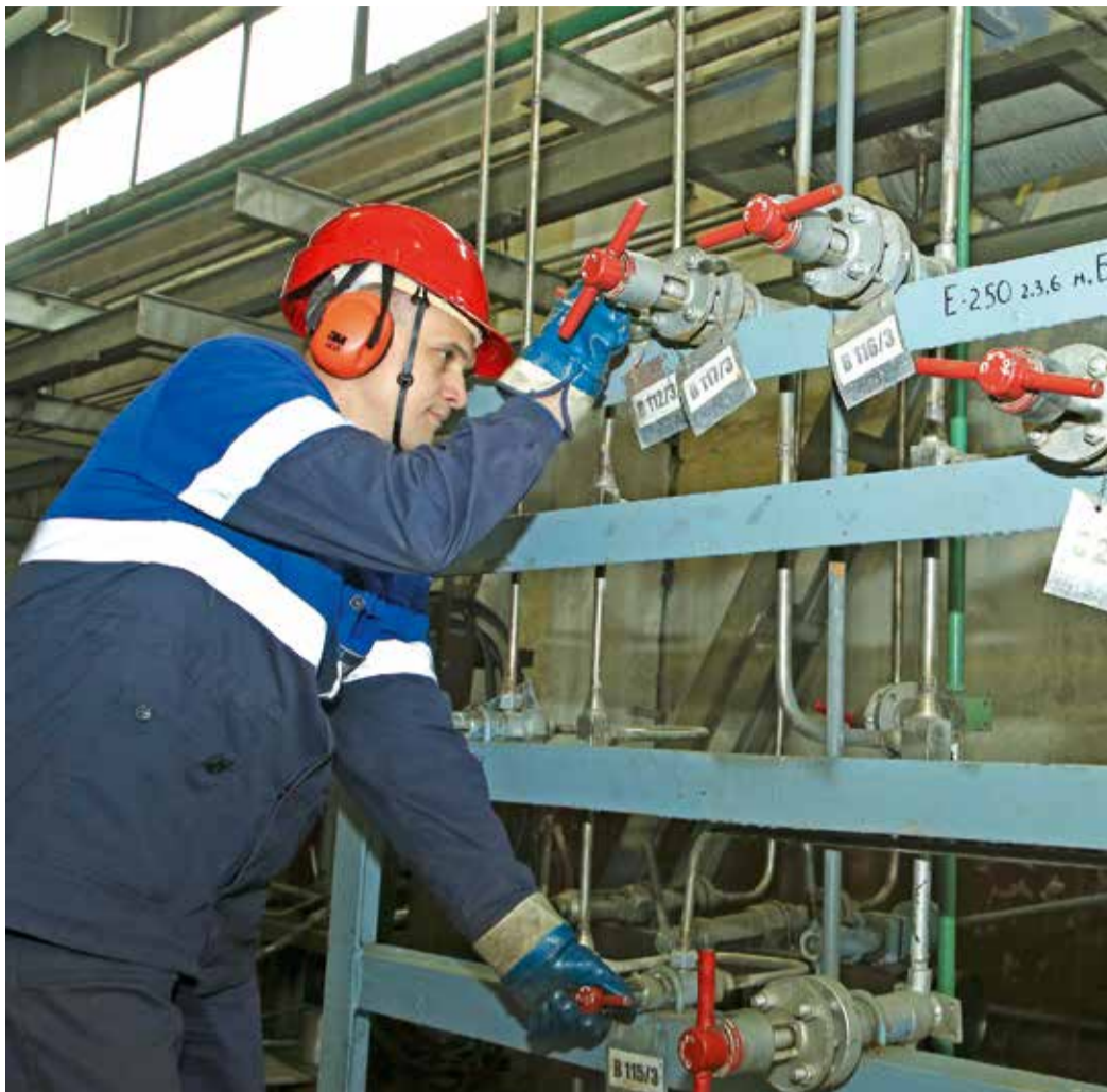
Оператор Александр Насонов останавливает компрессор для вывода на плановый ремонт
