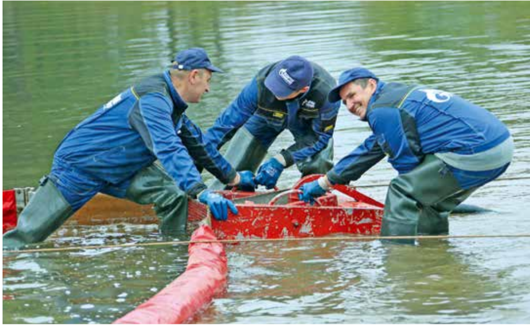
Ведется условный сбор нефтепродуктов с поверхности реки
