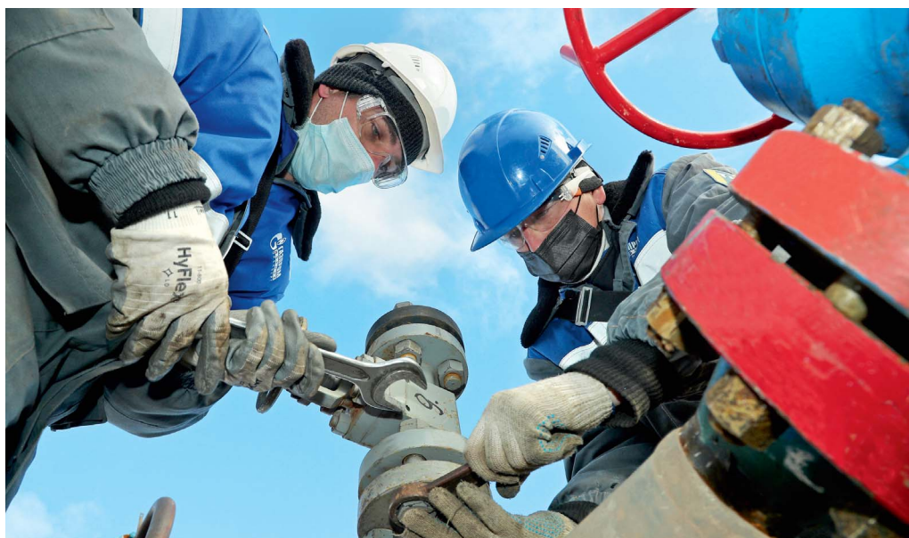
Операторы по добыче нефти и газа оперативно-производственной службы № 9 Александр Сумкин и Дмитрий Дивеев выполняют монтаж задвижки
