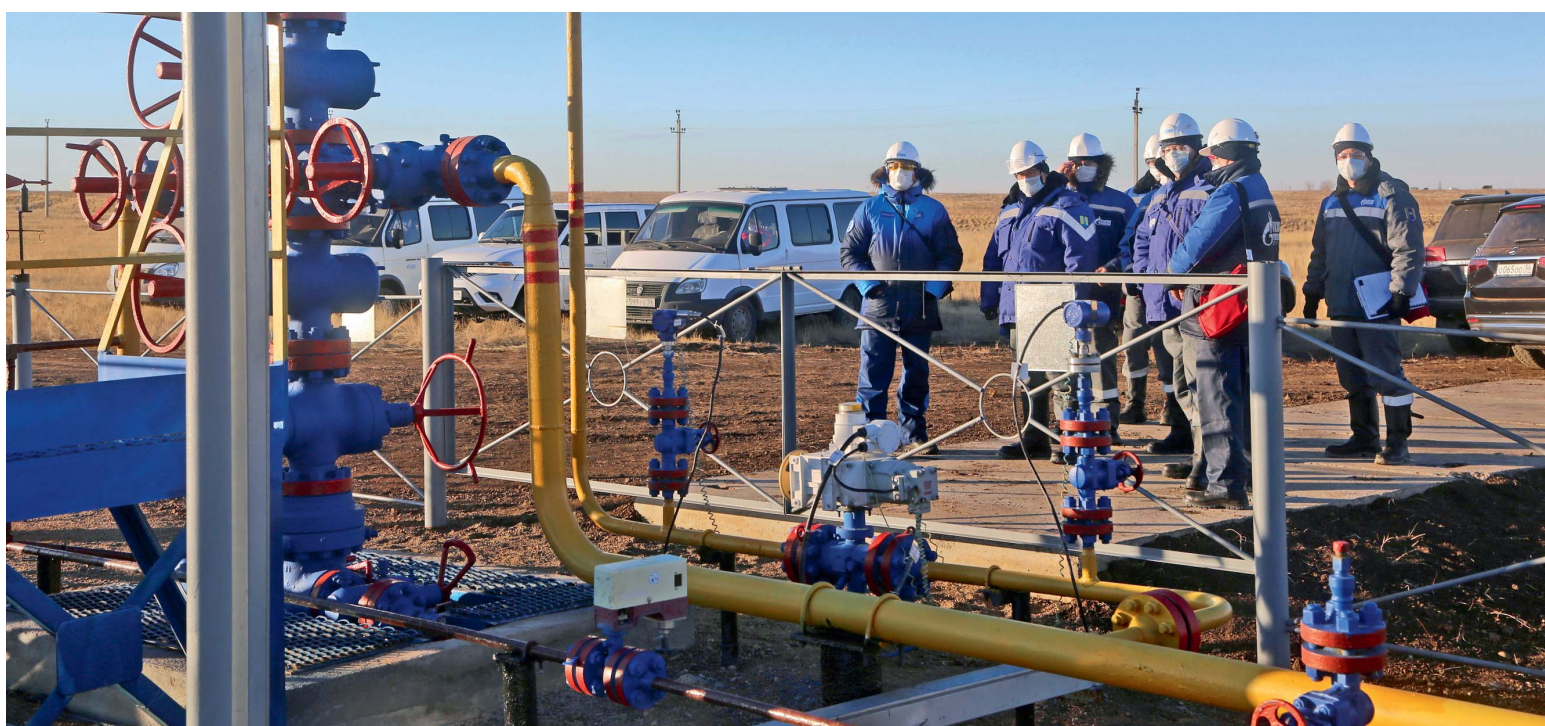
У скважины, на которой проводится испытание
