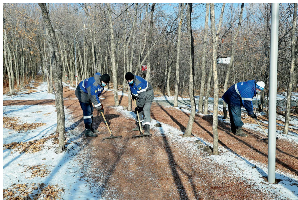
Завершение работ на терренкуре
