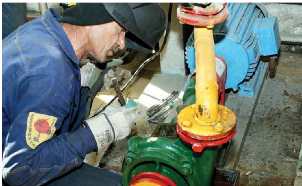
Производится ремонт насоса
