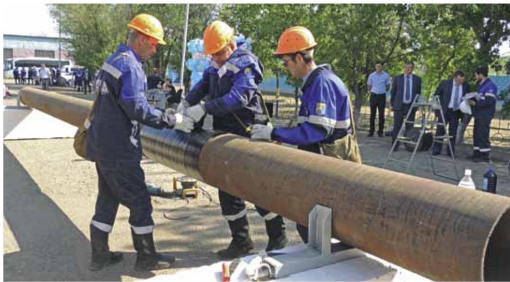
Качественная изоляция защитит от коррозии
