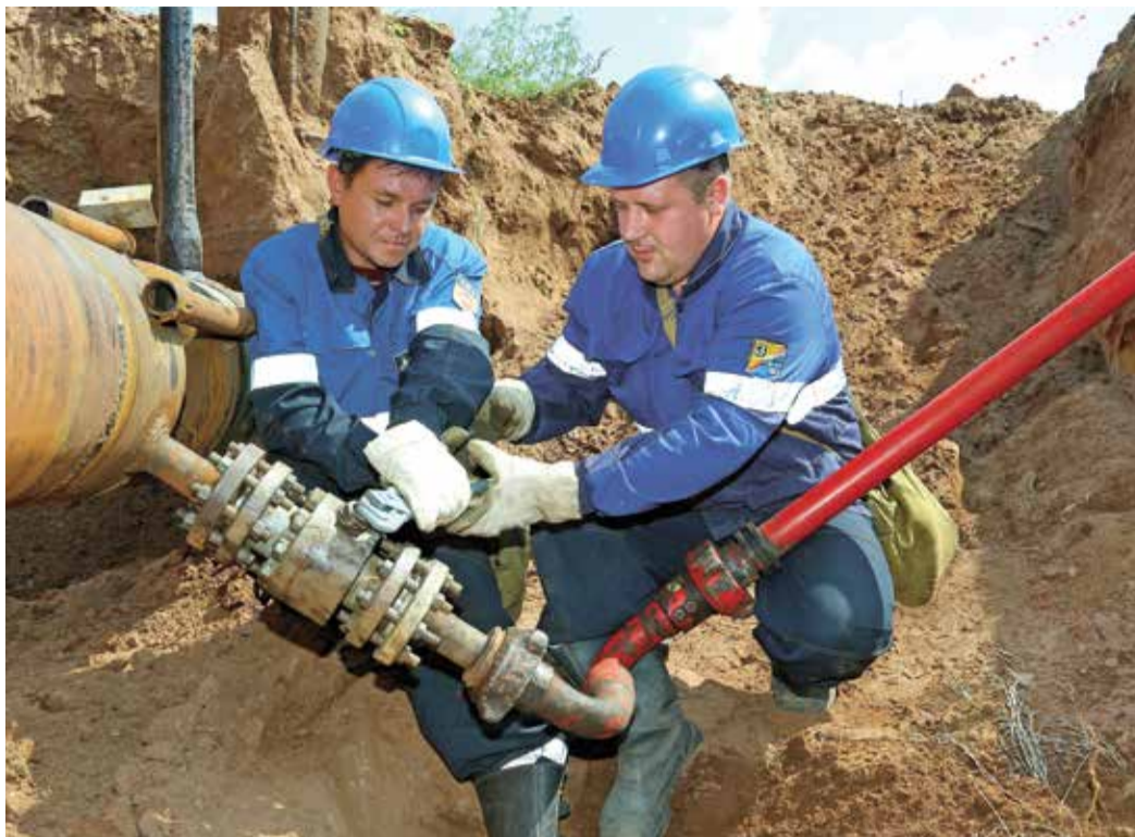
Трубопроводчики линейные Сергей Мазурин (слева) и Денис Кощеев демонтируют линию нагнетания
