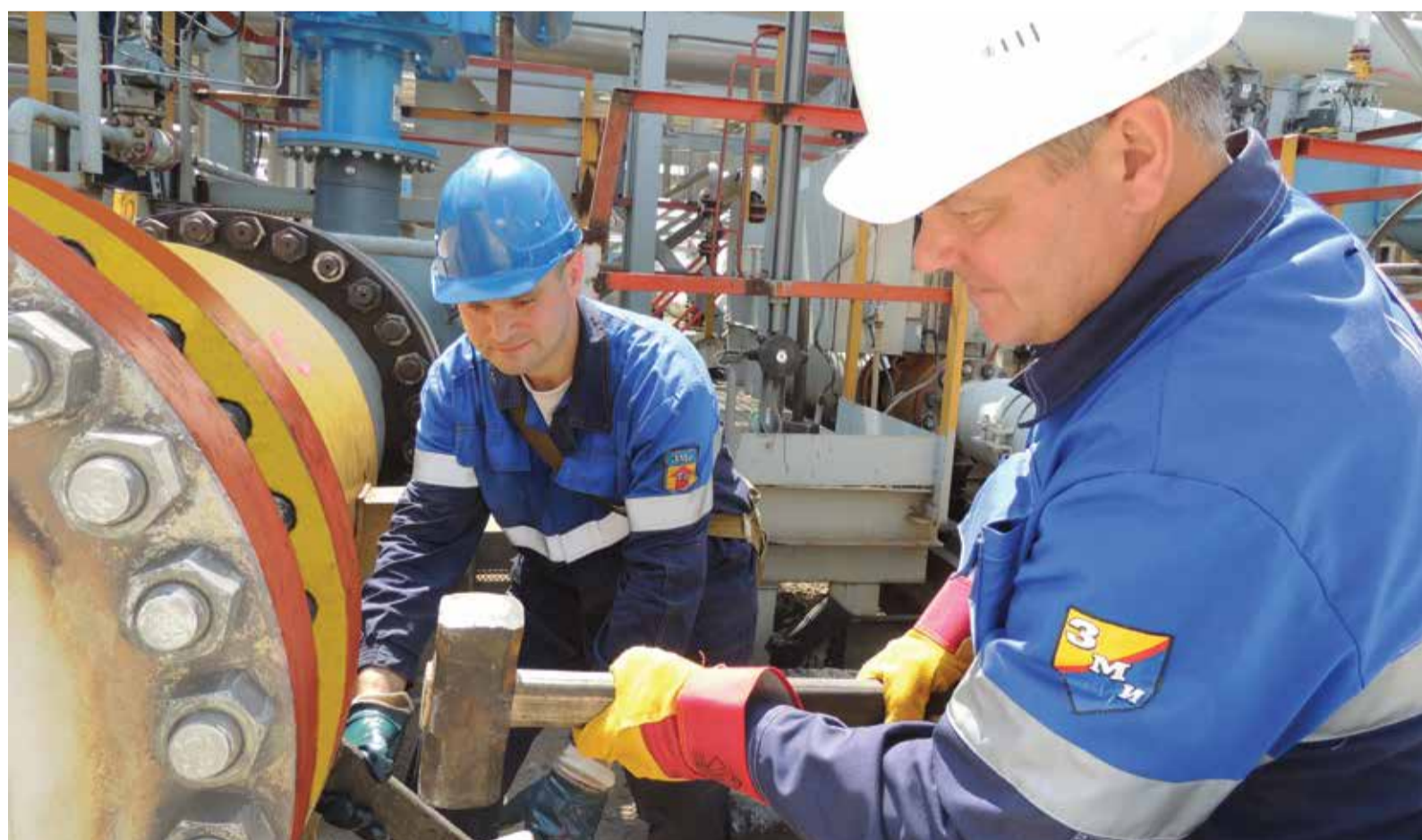
Монтаж обратного клапана на модульной обвязке
