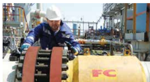
Ремонт газоперекачивающего агрегата № 5 завершен
