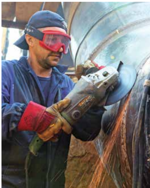
Монтажник технологических трубопроводов Мансур Рахматуллин проводит зачистку сварных соединений трубопровода
