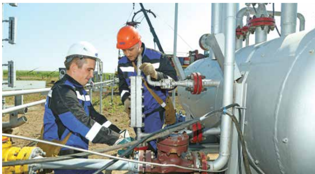
Ведется подключение блока сероочистки
