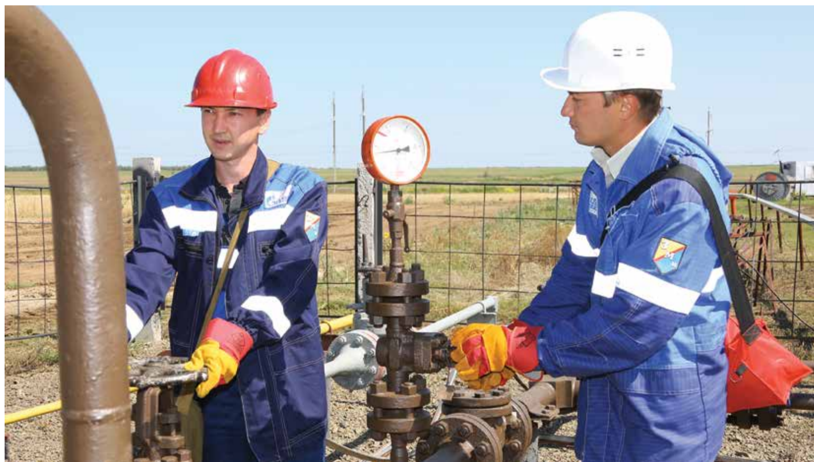
Скважина № 558н остановлена на капитальный ремонт
