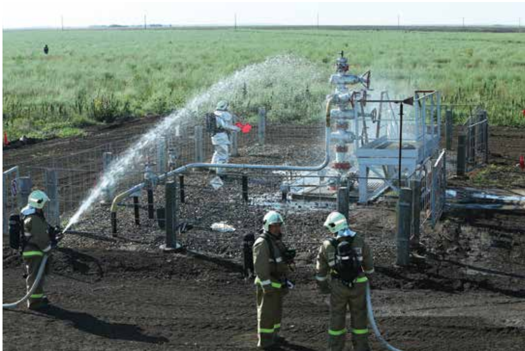
Охлаждающий душ для скважины
