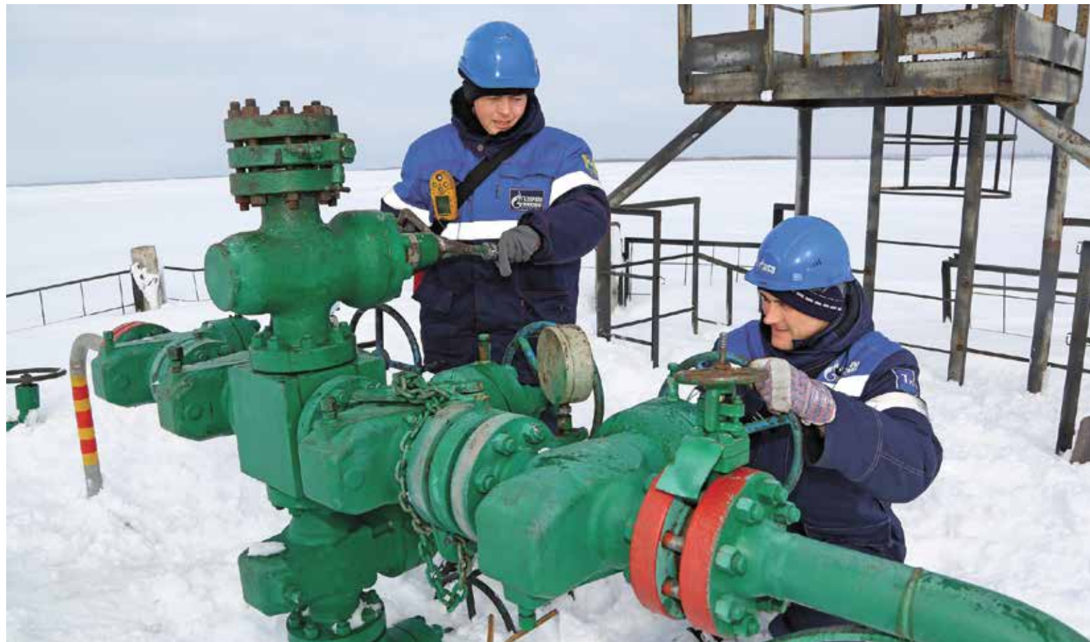
Операторы по добыче нефти и газа Валерий Хамидуллин (слева) и Евгений Матвеев ведут подготовку скважины к передаче на капитальный ремонт
