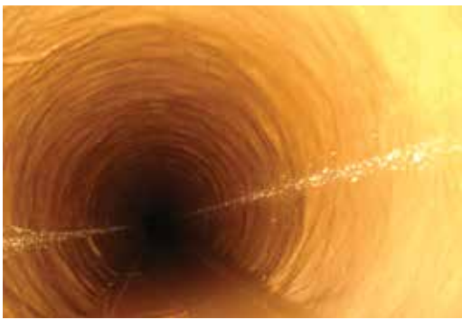
Обновленную трубу сфотографировал робот
