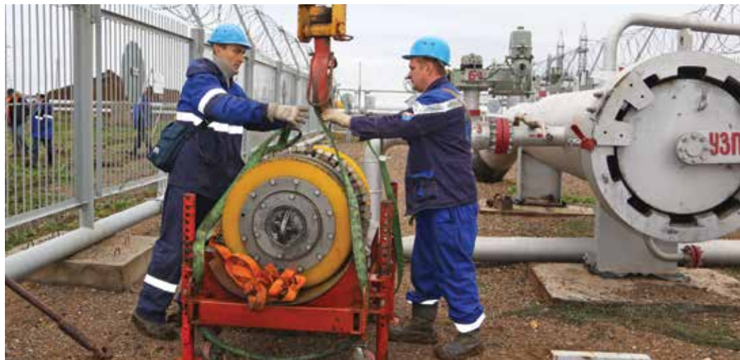
Магнитный дефектоскоп готовят к исследованию магистрали
