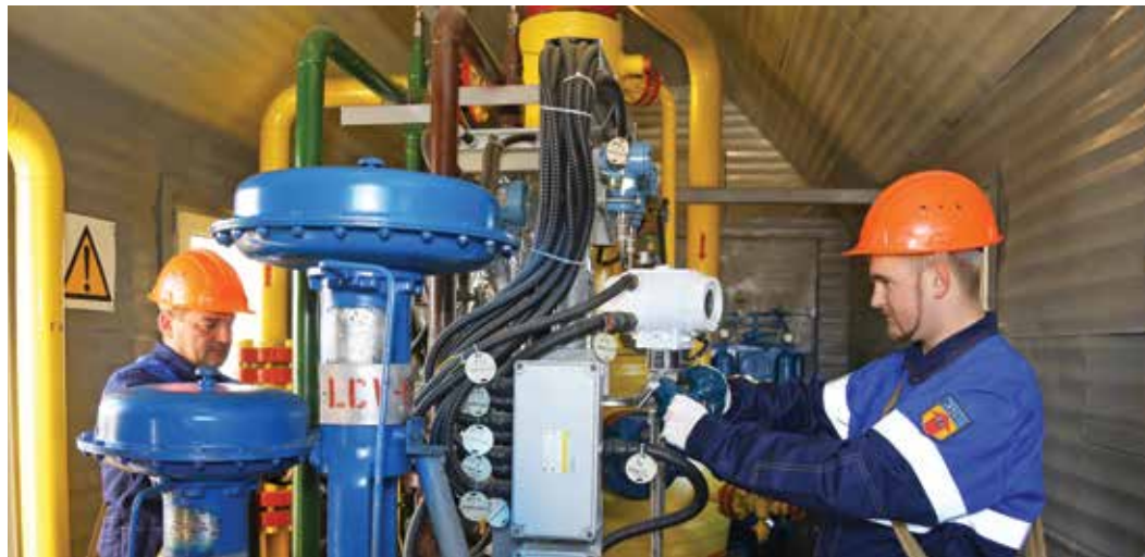
Проводится исследование скважин УКПГ-14
