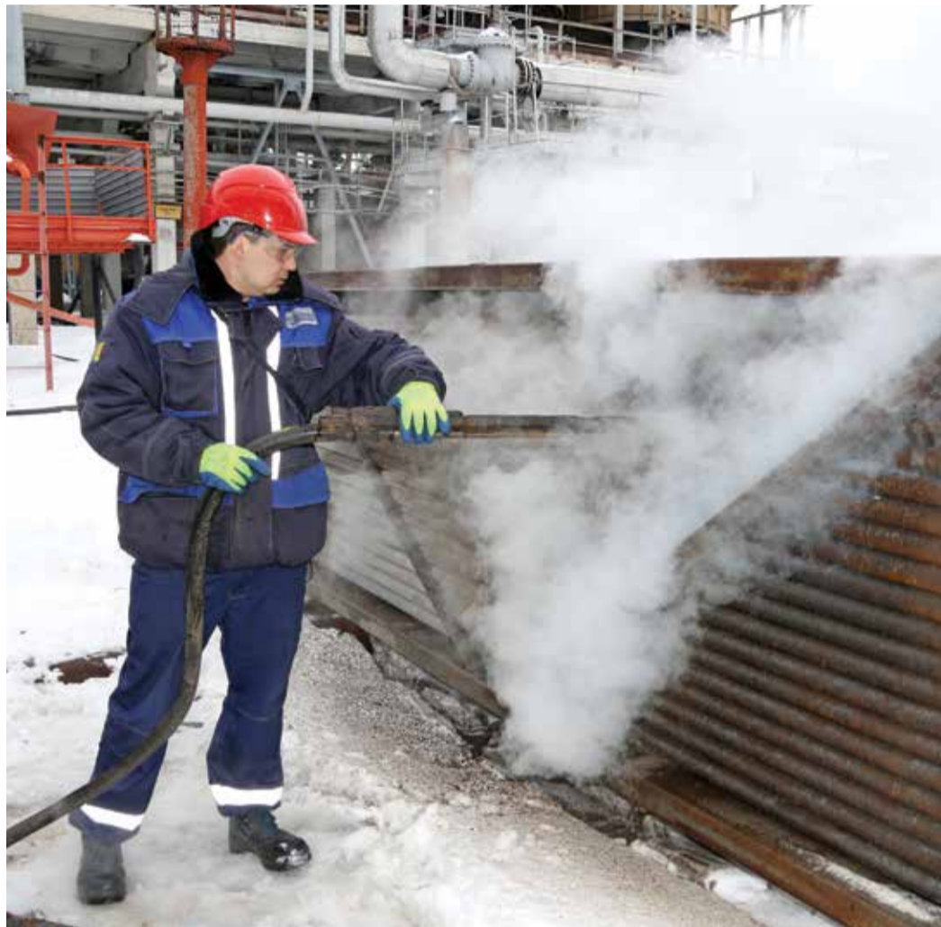
Машинист технологических компрессоров Алексей Бочкарев ведет пропарку секции аппарата
