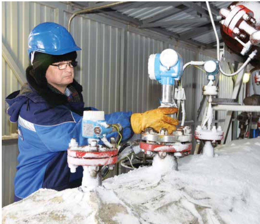
Мастер передвижного комплекса Владимир Барышев осматривает радарный уровнемер тестового сепаратора
