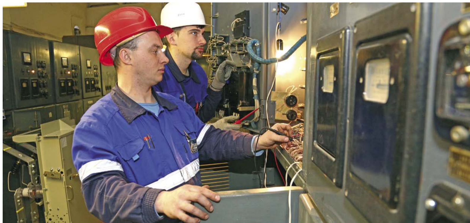
Ведется настройка обновленной распределительной ячейки
