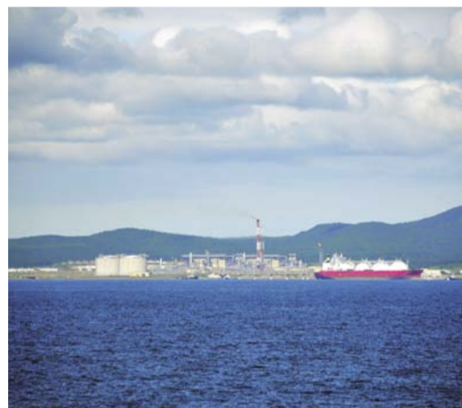
Завод по производству СПГ на Сахалине
